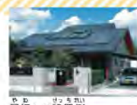
屋根への設置例
