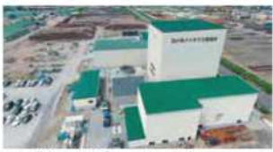
北海道産の間伐材100%で電気をつくる日本でもめずらしい苫小牧バイオマス発電所
